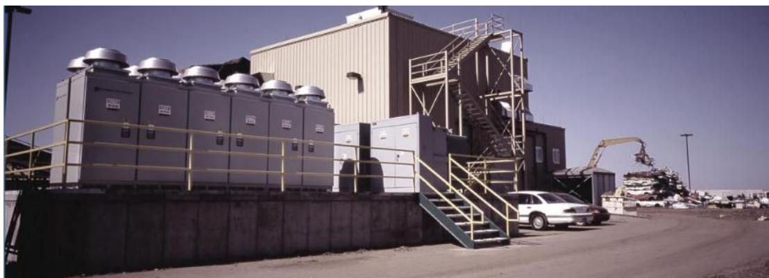
شکل ۹-۸: جبران سازی توان راکتیو کارخانه بازیافت فلز
