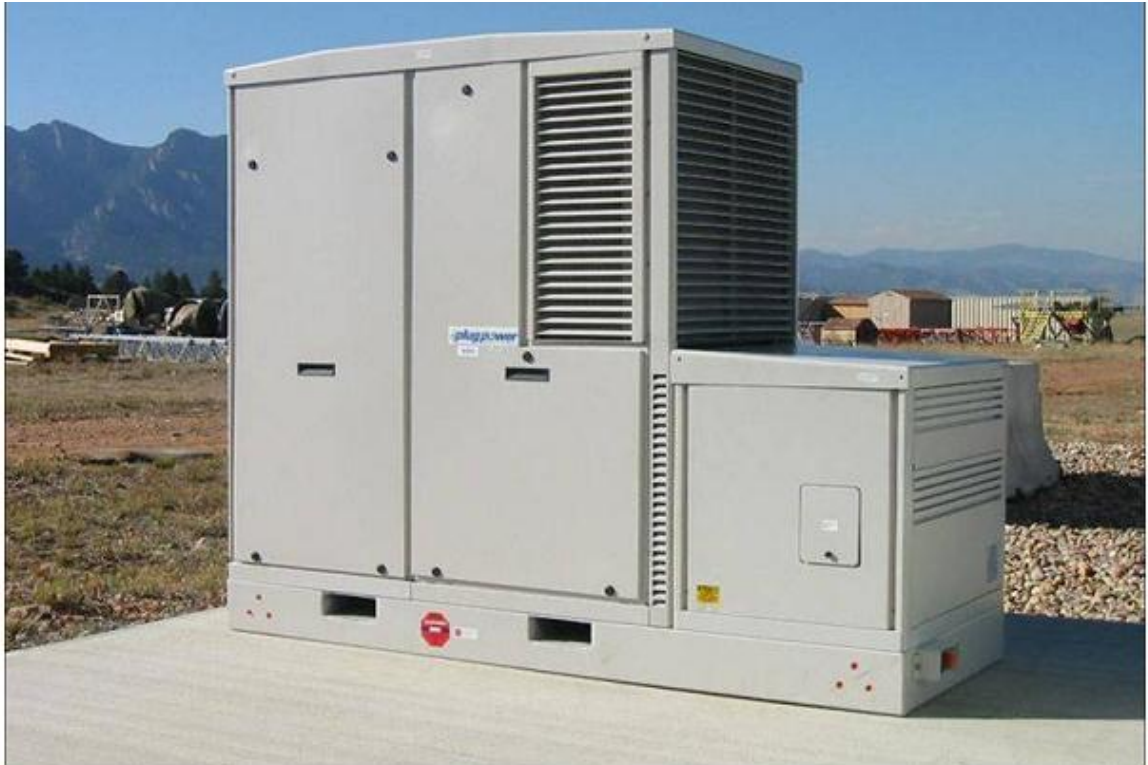
شکل (۲-۶۱): پیل سوختی و اینورتر مربوطه
