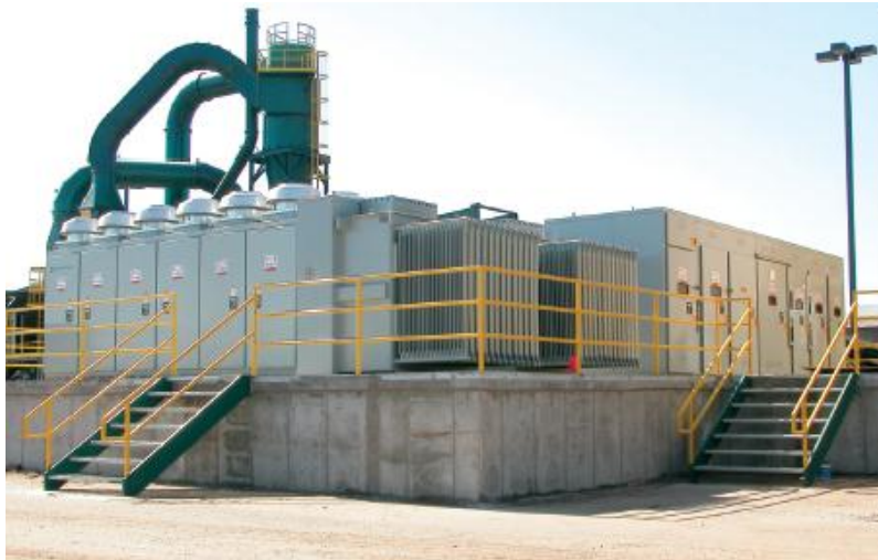
شکل ۹-۵: جبران ساز جریان راکتیو و تصحیح کننده کیفیت توان PureWave AVC
