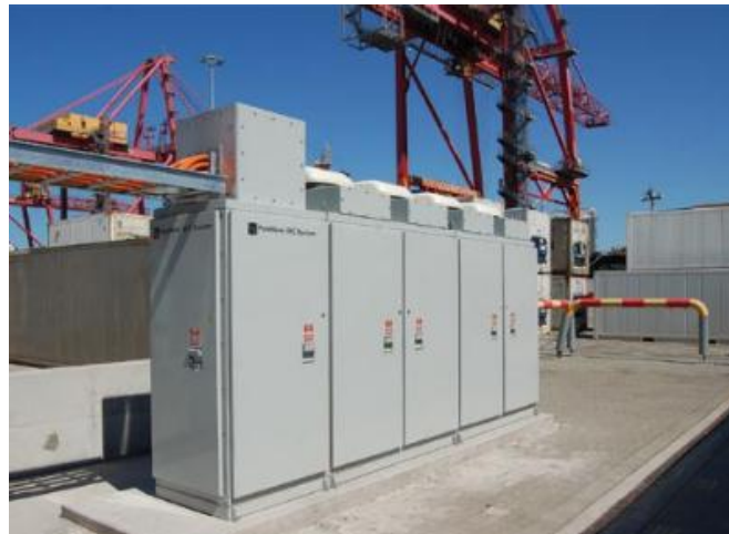
شکل ۹-۹: جبران ساز توان راکتیو در بارانداز اسکله
